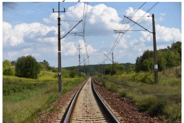
Fot. 54. Torowisko linii kolejowej Nr 25 Łódź Kaliska – sołectwo Stary Garbów
