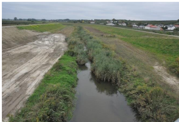
Fot. 56. Budowa obwałowania odcinka ujściowego Koprzywnicy i Gorzyczanki
