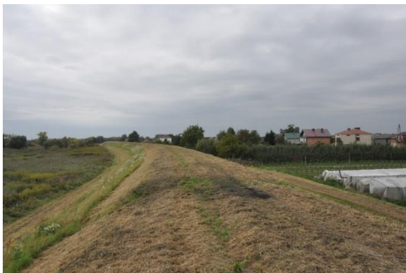
Fot. 55. Terasa zalewowa Wisły z wałem przeciwpowodziowym – Bogoria Skotnicka
