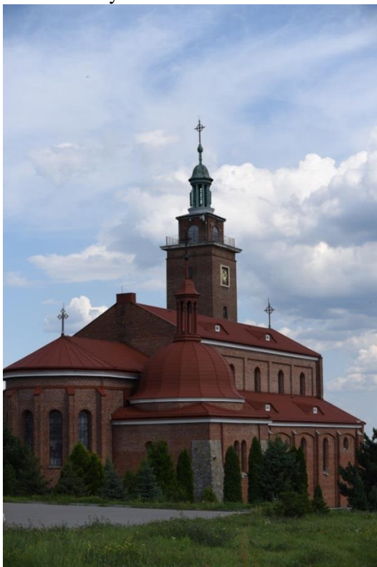
Fot.71. Kościół pw. św. Andrzeja Boboli i św. Antoniego Pustelnika – posadowiony na lessowym wzniesieniu w Dwikozach
