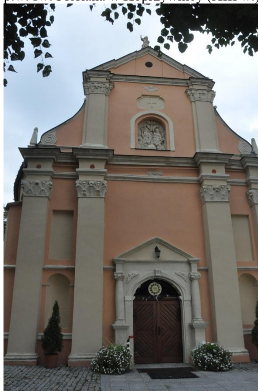
Fot. 66. Kościół w Samborcu pw. Świętego Trójcy
