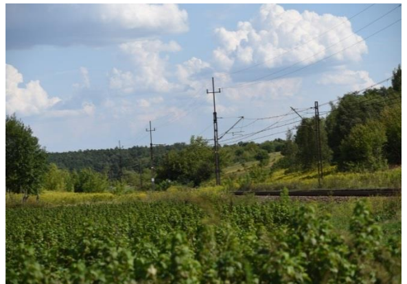
Fot. 52. Linia kolejowa Nr 25 Łódź Kaliska – w sołectwie Góry Wyższe
