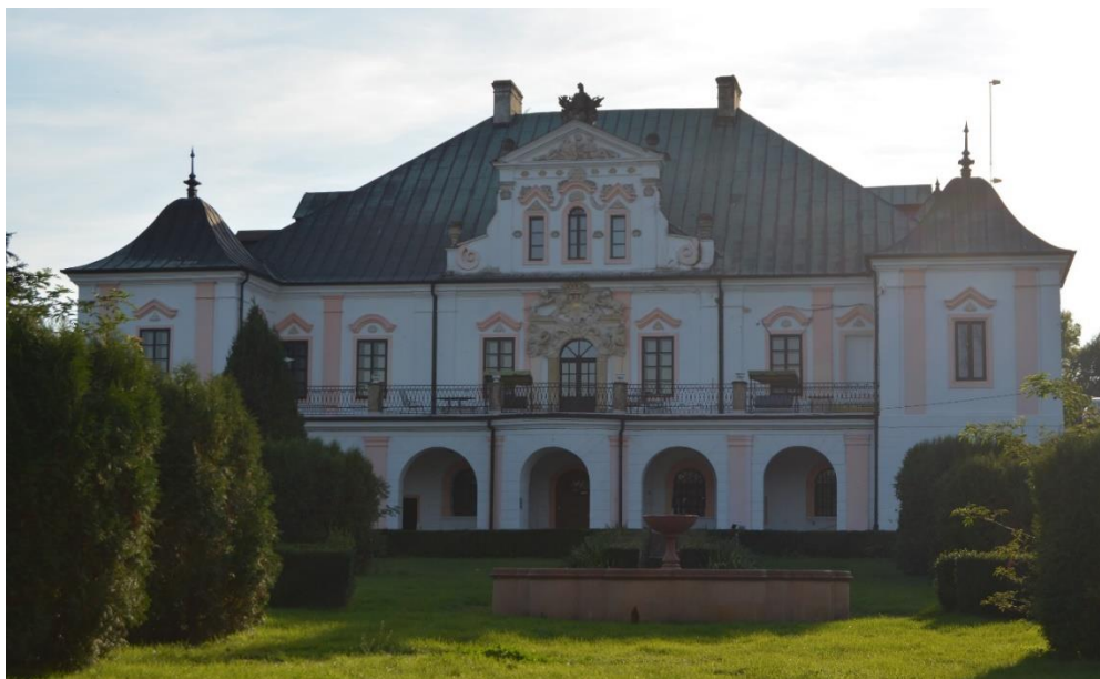
Fot. 6. Czyżów, fasada późnobarokowego pałacu (Fot. A. Świercz).
